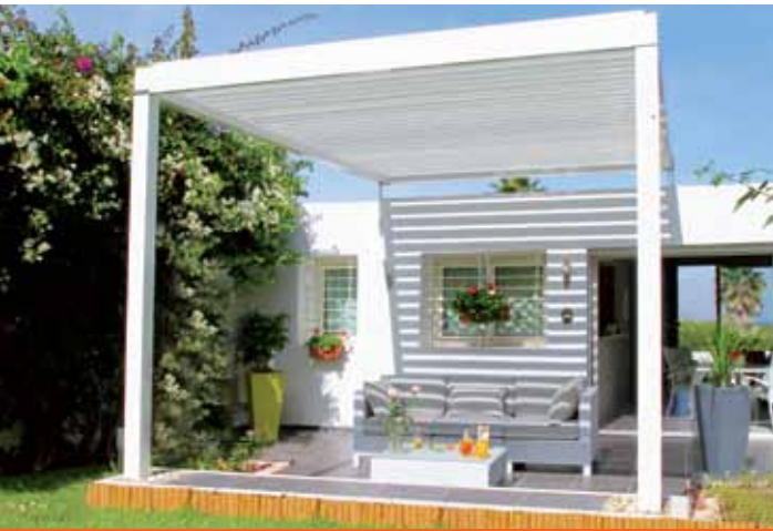
Un module adossé à un mur et sur 2 poteaux
