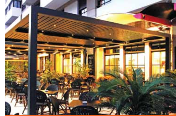
Module isolé sur 4 poteaux.
