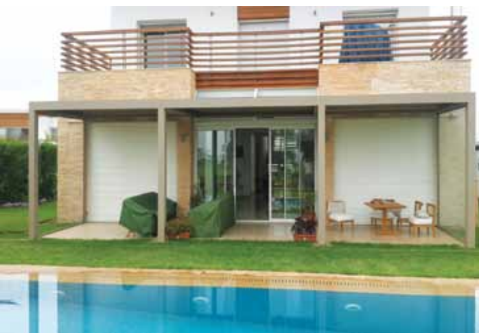
Plusieurs modules adossés sur poteaux.
